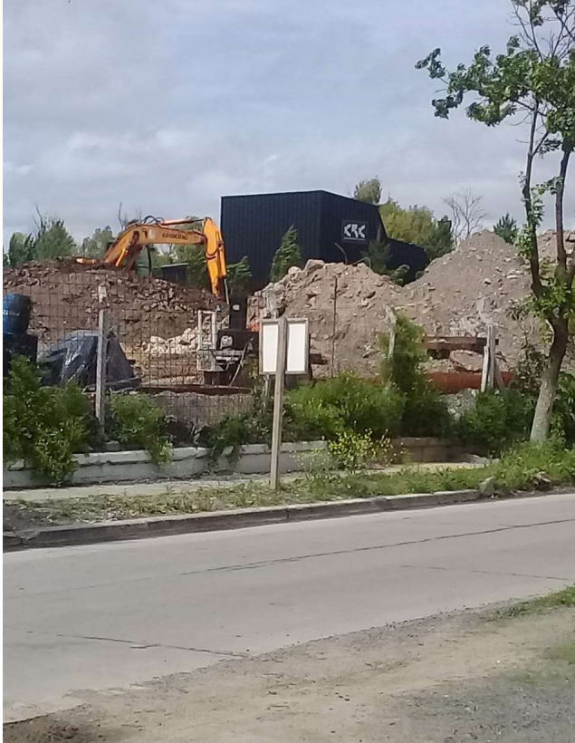
Imagen 1. Acopio de restos de material procesado de la construcción.
