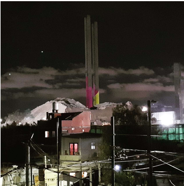
Imagen 4. Fotografía tomada desde el balcón de un vecino donde se observa la montaña de acopio de la planta.
