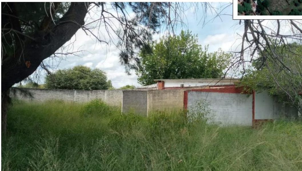
vista interior del predio, malezas y especie de box de estacionamiento.
