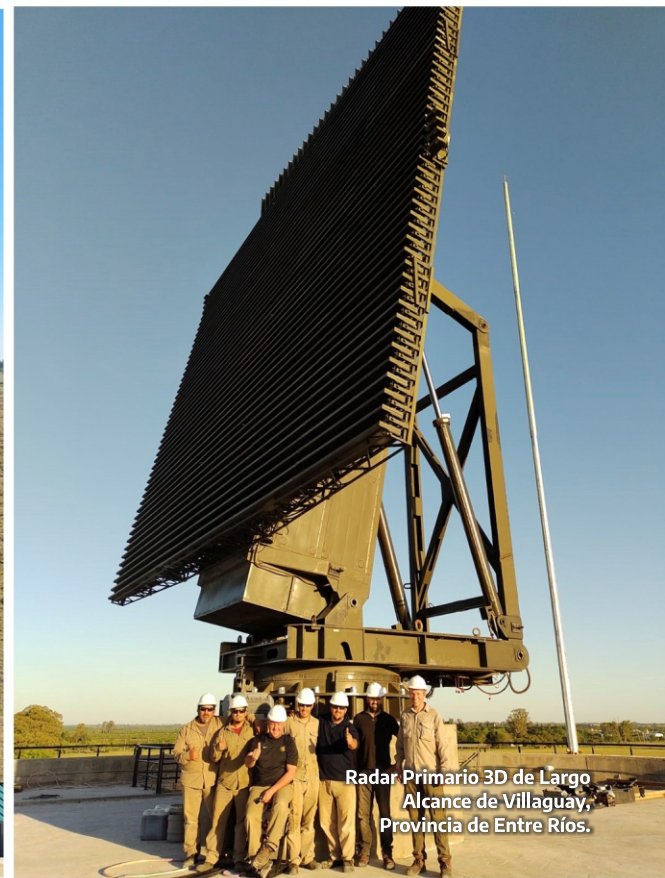
Personal de INVAP S.E. trabajando en montaje de radomo. Mercedes, Provincia de Corrientes.
