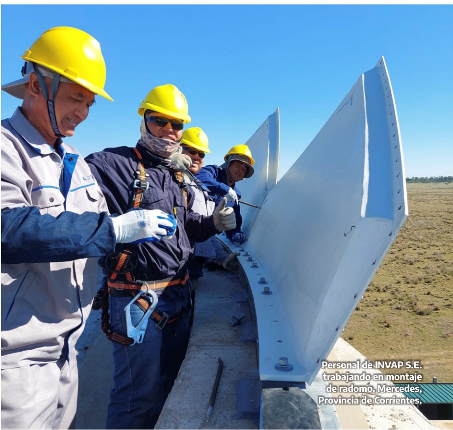
Montaje de radomo para Radar Primario 3D de Largo Alcance en Mercedes, Provincia de Corrientes.
