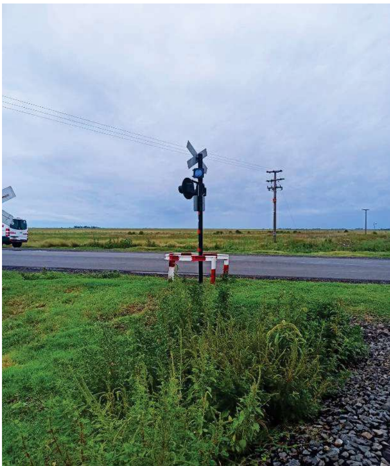
Figura 11. Señal fonoluminosa (sin barrera) en estado operativo. Fuente: JST, 2023
