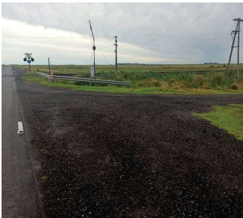
Figura 5. Bocacalle lado este, desde la RN 7. Fuente: JST, 2023
