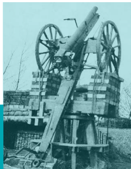
CAÑÓN DE ARTILLERÍA DE CAMPAÑA CON SOPORTE IMPROVISADO PARA REALIZAR FUEGO SOBRE AERONAVES.
