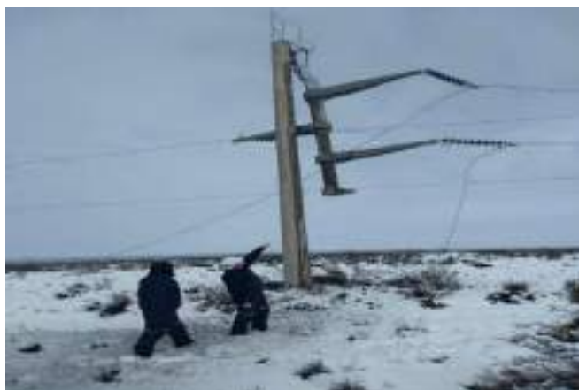
Ejemplo de estructura soporte colapsada
