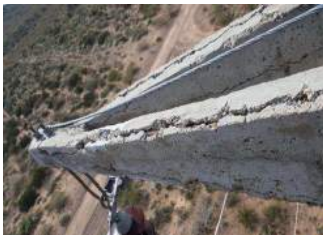
Deterioro en ménsula de LAT 132kV PSecc-Rincón
