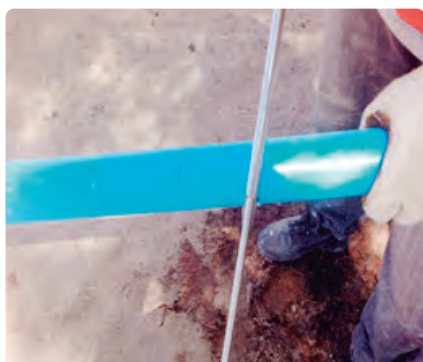
FOTO 06.c Ranurado del tubo.
