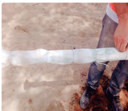
FOTO 06.d Protección con tela permeable.
