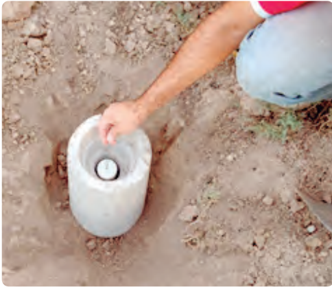
FOTO 07.c Base de hormigón y tapa plástica.
