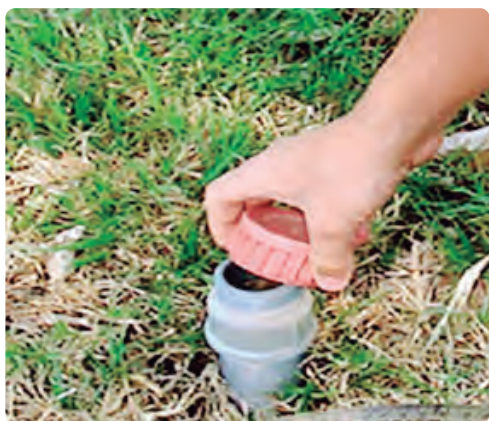
FOTO 07.a Terminación con tapa roscada.
