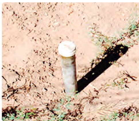
FOTO 07.b Terminación con tapón de 50 mm.
