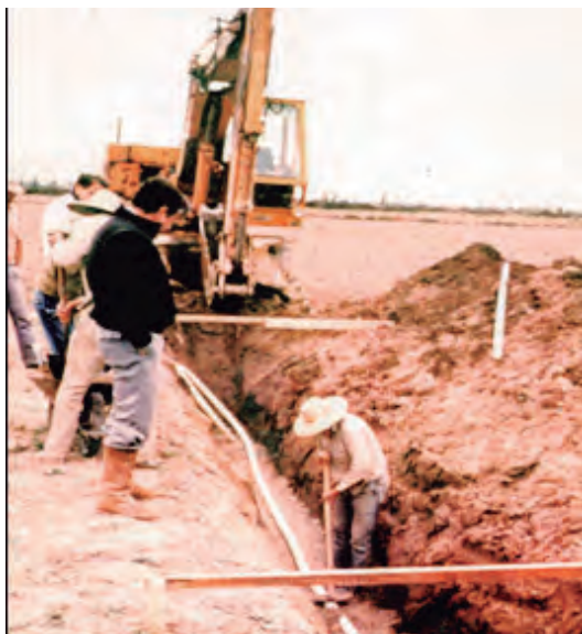
FOTO 11 Construcción de un dren entubado.
