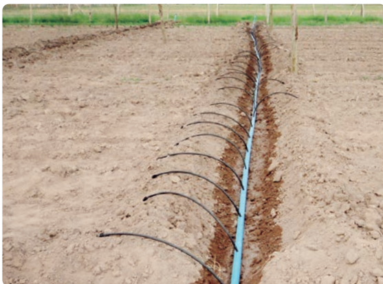
FOTO 12 Detalle de conexión de laterales a la tubería terciaria.
