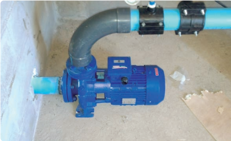
FOTO 03 Bomba centrífuga de riego.
