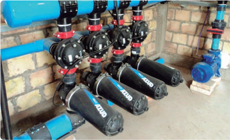
FOTO 09 Equipo de riego con filtrado de anillas.
