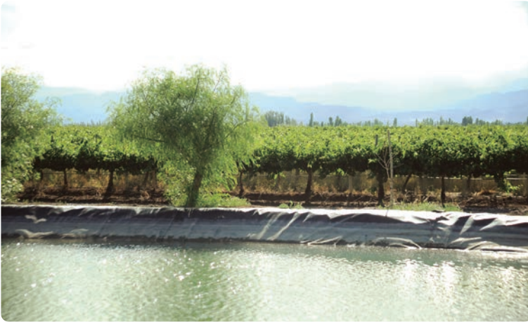
FOTO 01 Reservorio con geomembrana.
