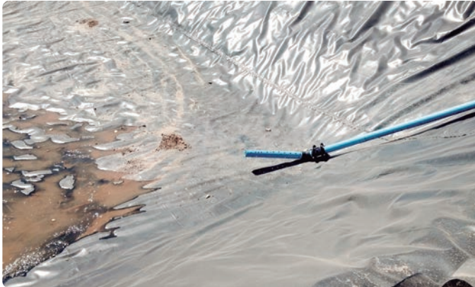
FOTO 04 Canasto de protección en la zona de succión.
