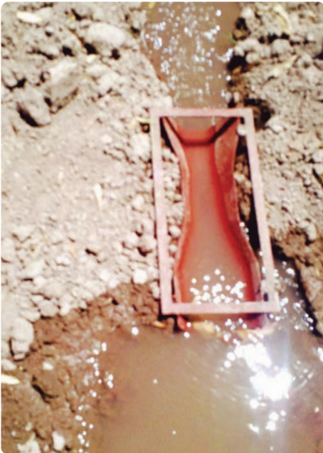
FOTO 06 Aforador para pequeños caudales.
