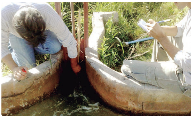
FOTO 03 Aforo de compuerta.
