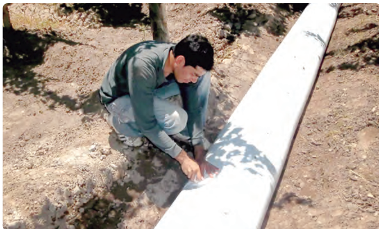
FOTO 08 Instalación de campo.
