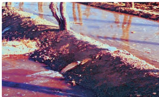
FOTO 07 Instalación de tubos a nivel.
