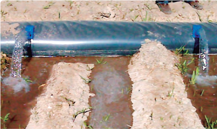
FOTO 10 Detalle de compuertas
