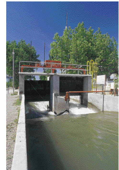
▲ Grandes compuertas sobre el canal matriz San Martín. Mendoza.
