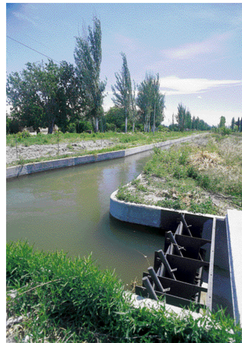
▲ Canal Nuevo Ratamo, Montecaseros. Proyecto Área de Riego Constitución. Mendoza.
