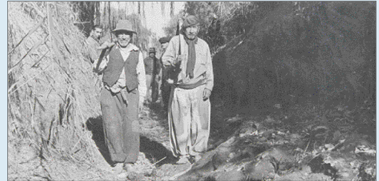
▲ Trabajadores de pala en el Canal Montecaseros (1956). Departamento de San Martín. Mendoza.
