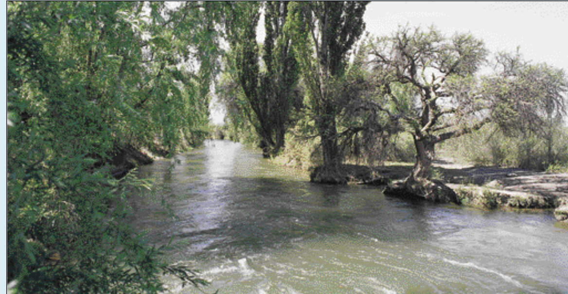
▲ Futura obra: Canal Reducción. Mendoza.
