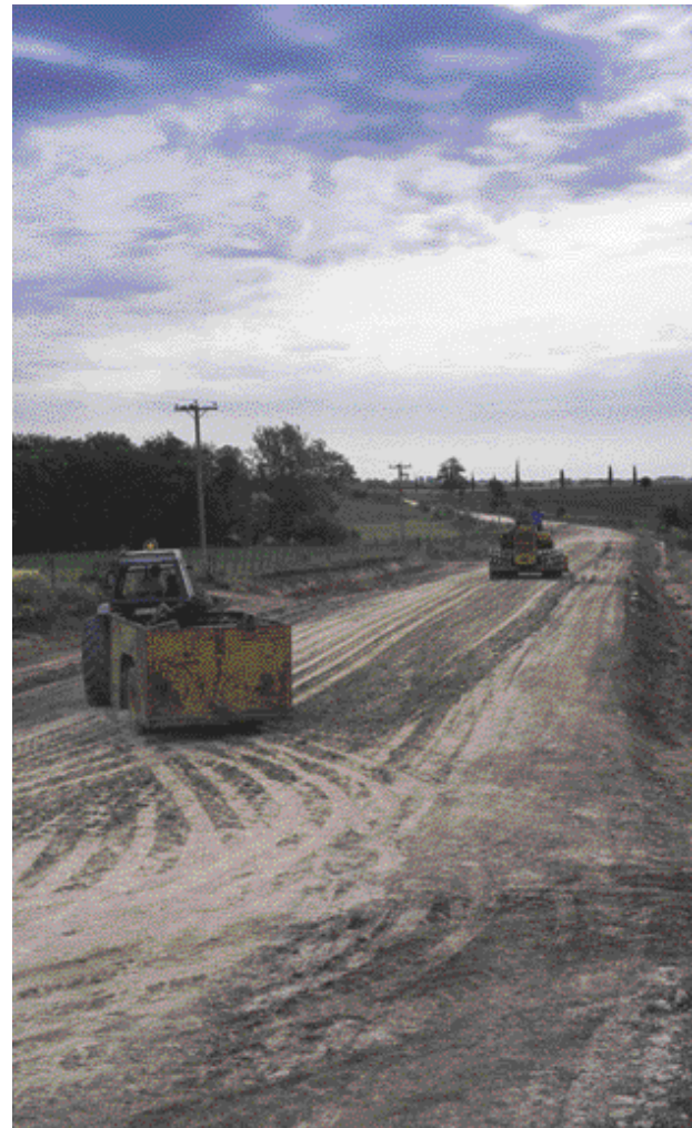
▲ Compactando la base del suelo calcáreo. Entre Ríos.
