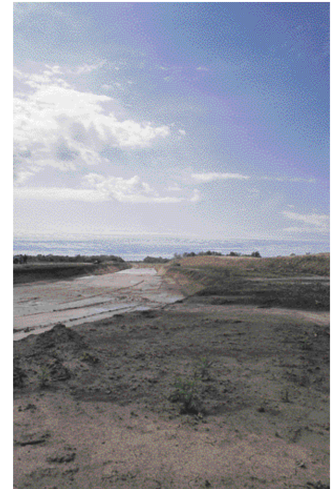
Proyecto de Saneamiento Hídrico de la Línea del Tapenagá. Inicio de conexión Bajo Hondo I y II. Chaco.
