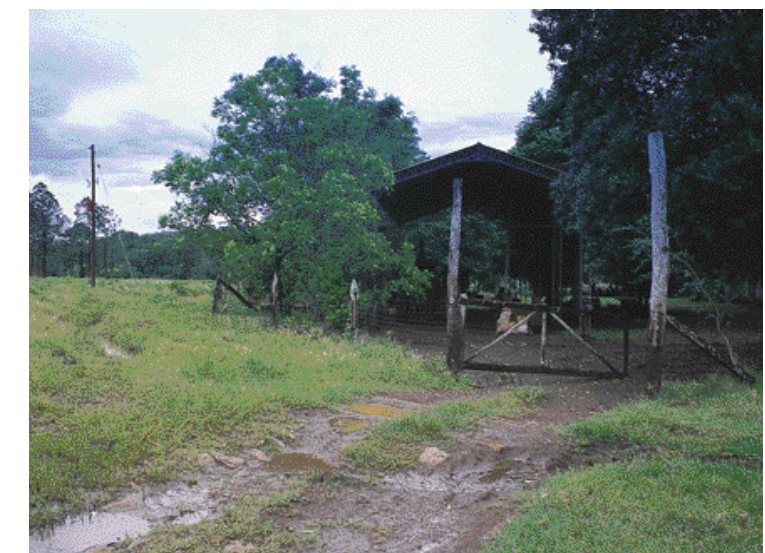
▲ Vivienda de un usuario en un proyecto de electrificación rural en Misiones.
