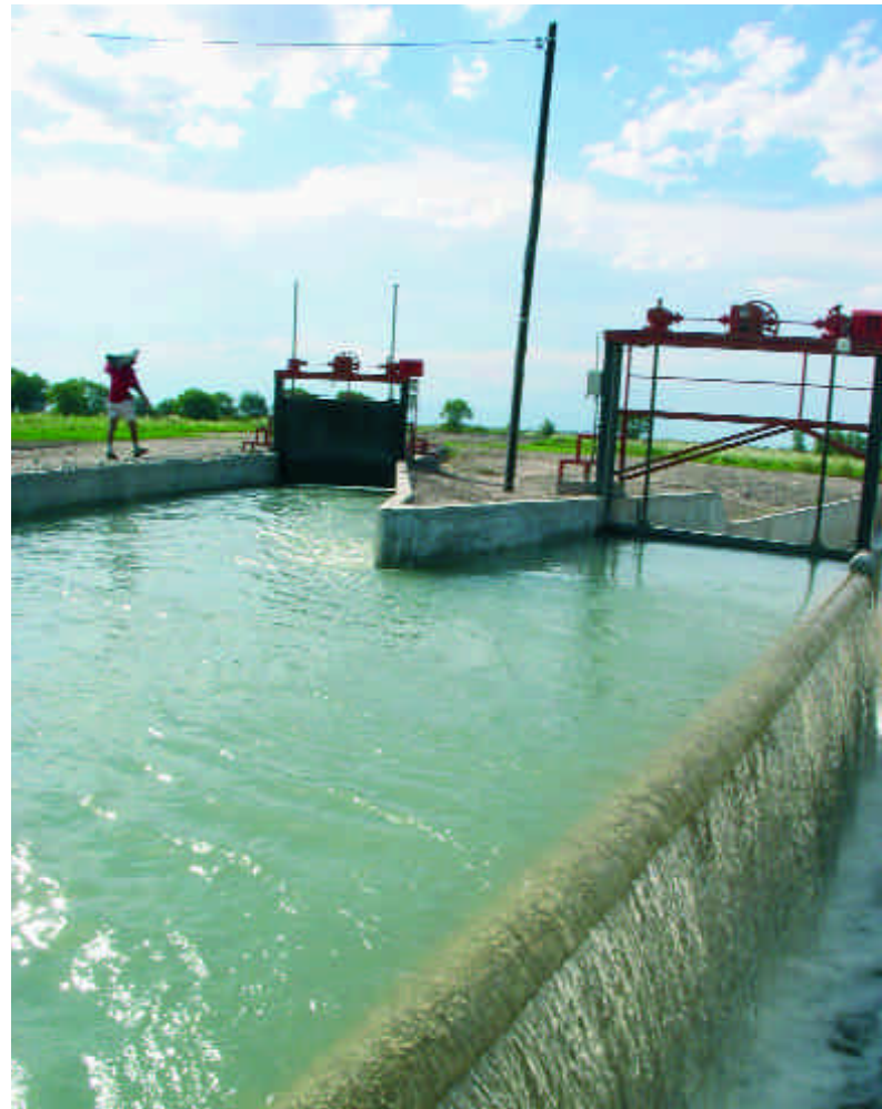
▲ Proyecto Rehabilitación del Tramo Inferior Río Mendoza. Quinto Tramo.
