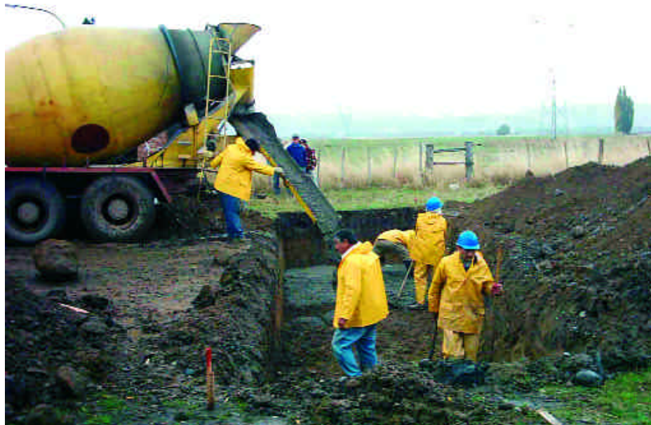
Primera y segunda fotos ▲ Construyendo canales en Trevelin.
