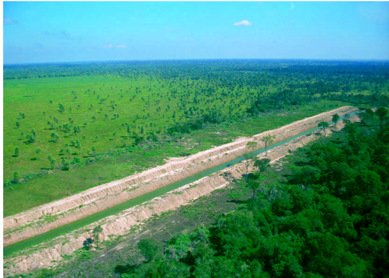
▲ Vista aérea del proyecto Tapenagá. Chaco.
