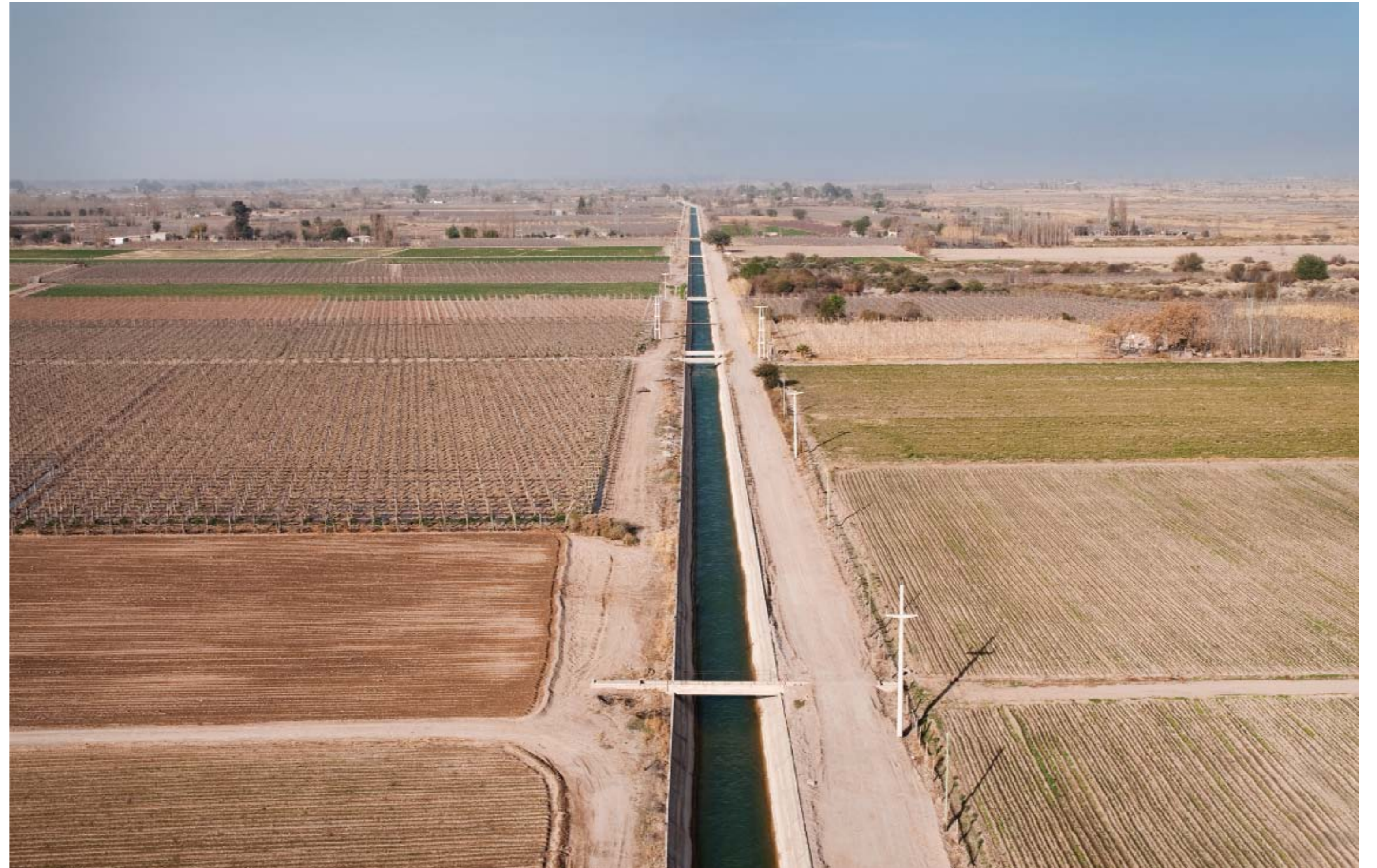
Pág. 158 - Dique Arroyo Las Tunas, Departamento Túpungato, Mendoza. Pág. 159 - Canal del Norte, comparto Cauce de. Departamento Cauce de, San Juan. Págs. 160 y 161 - Vista aérea del Canal del Norte. Departamentos Albarcón y Angaco, San Juan.
