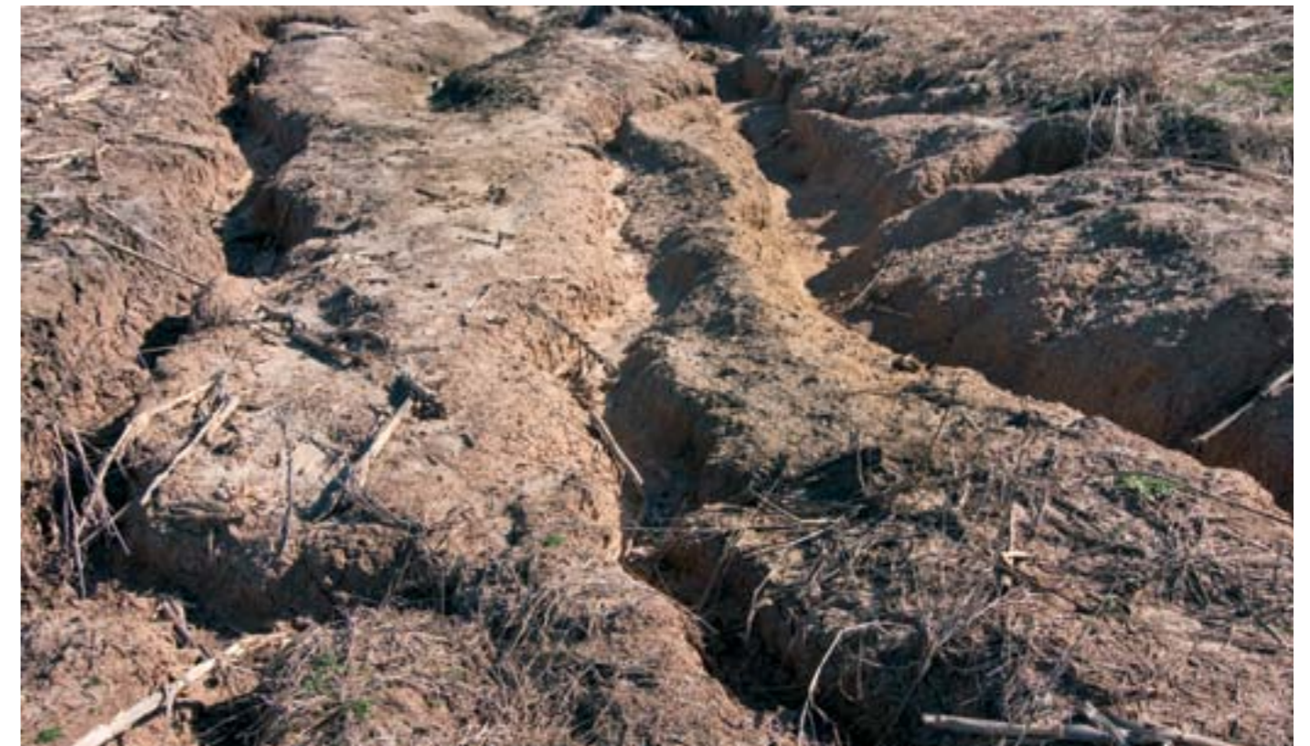
Fotografía 1: Daños en suelo producidos por el escurrimiento del agua. Fuente: Luis Crusta.
