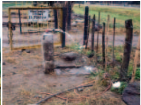
Foto 10: Grifo junto al ingreso a la propiedad.
