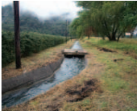
Foto 5: Canal matriz aguas arriba de la propiedad.
