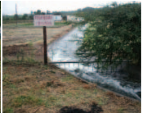
Foto 6: Vista del canal matriz frente a la propiedad.
