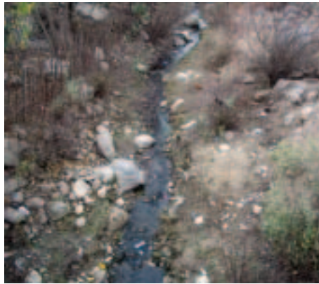
Foto 27. Desagüe subsistema Molle Solo. Vista hacia aguas abajo.
