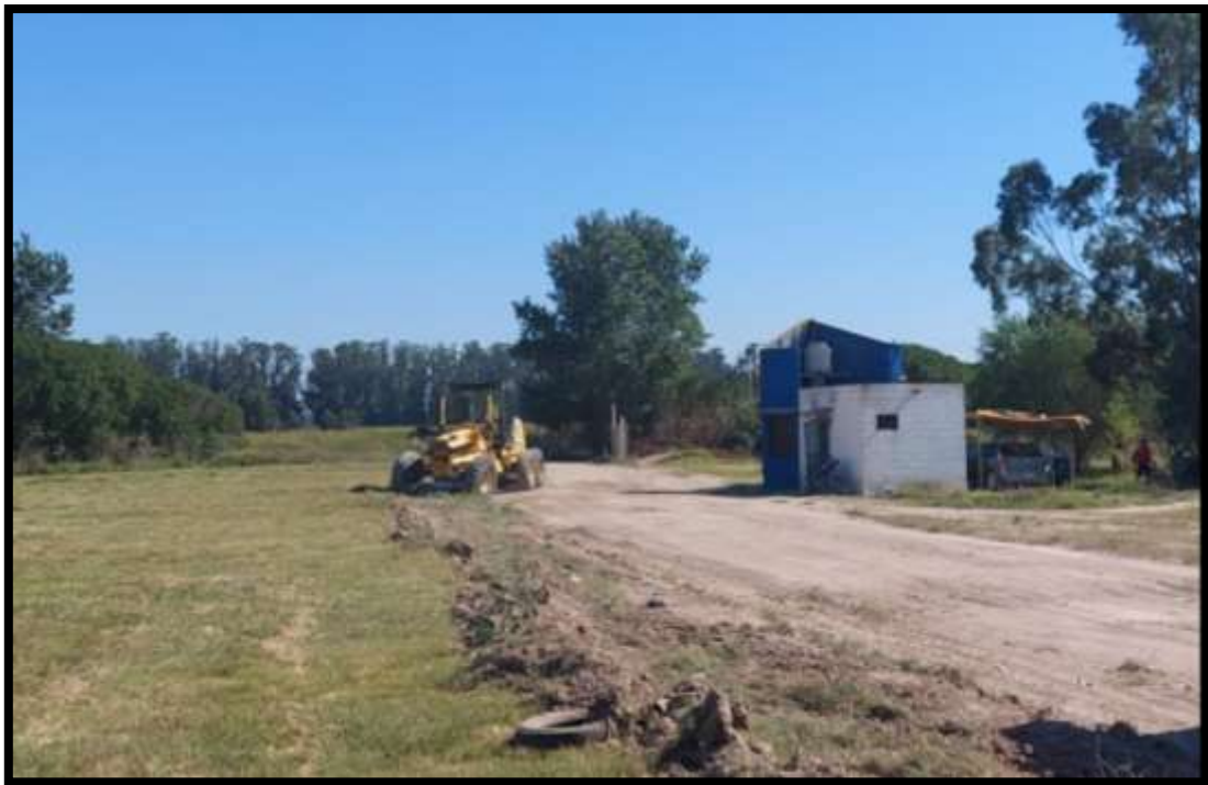
Figura 53 - Camino de ingreso al predio
