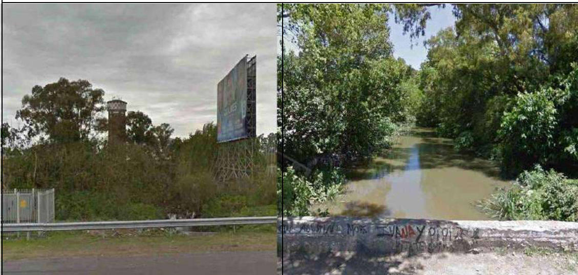
Figura 10. Arroyo Colorado en su cruce con la Au. Buenos Aires-La Plata
