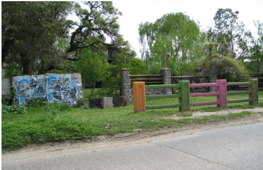
Figura 2.11. Pequeña estructura de control sobre Av. Cervantes.
