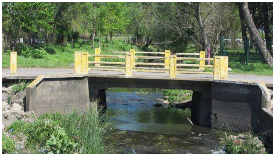
Figura 2.30. Puente Arroyo Colorado y Av. Cervantes.
