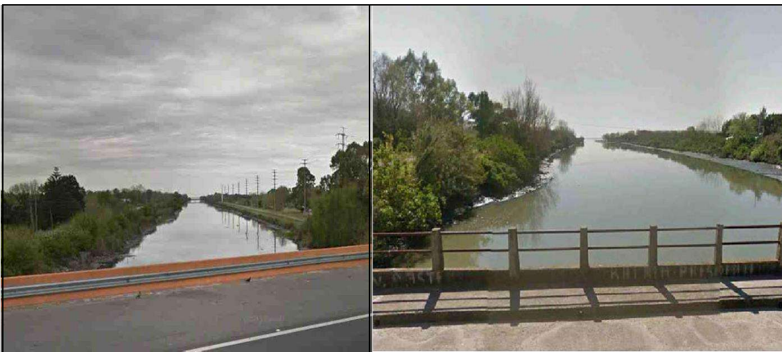
Figura 2 y Figura 3. Canal Santo Domingo en su cruce con la Au. Buenos Aires-La Plata (izquierda) y con vistas a su desembocadura (derecha)
