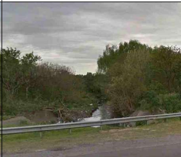
Figura 7. Canal Monteagudo en su cruce con la Au. Buenos Aires-La Plata
