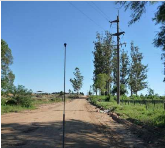
Camino de tierra afirmado de acceso al predio Campo EL Abasto
