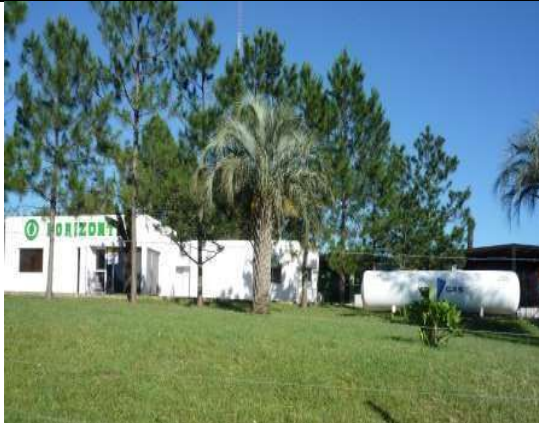
Empresa Horizonte Gases SRL. Se ubica al sureste del predio
