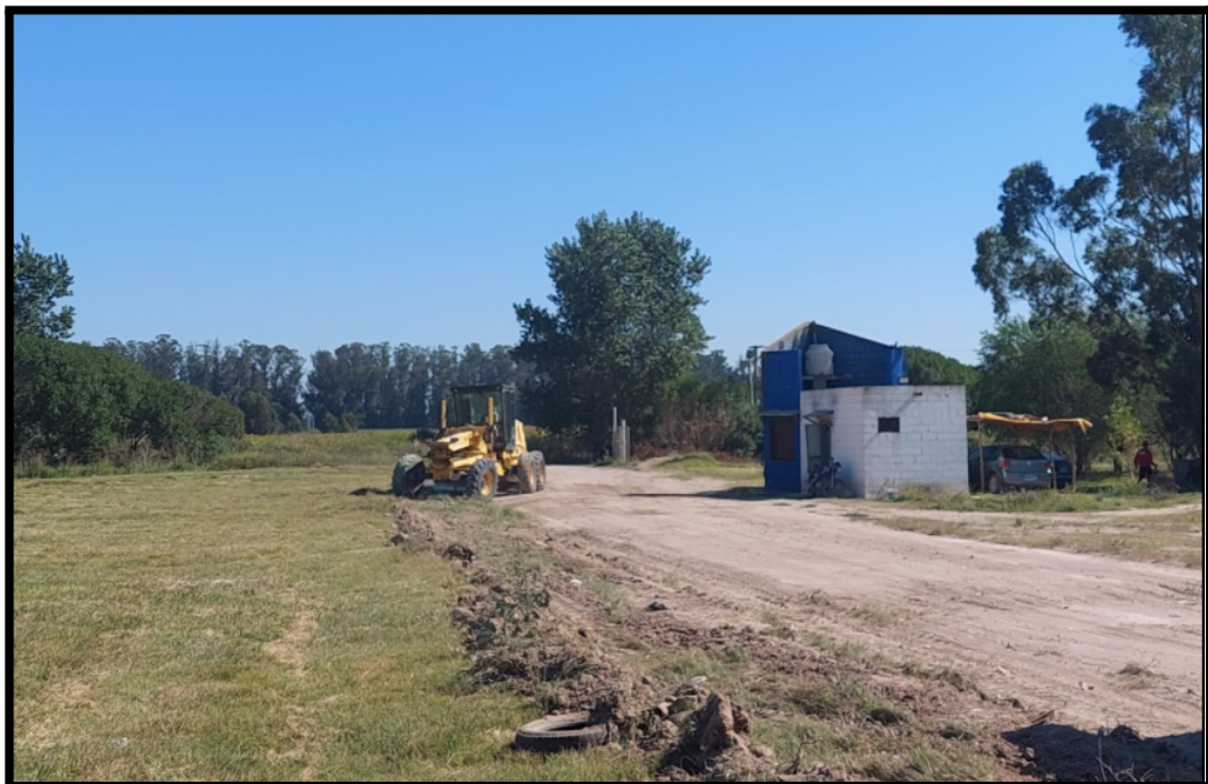
Figura 53 - Camino de ingreso al predio.
