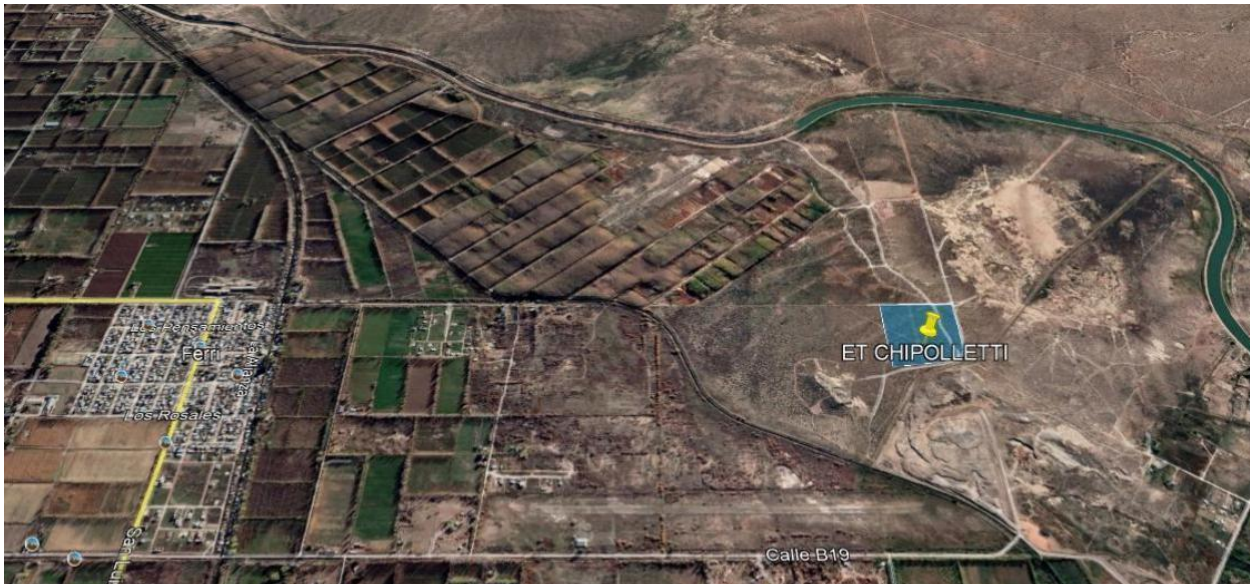
Figura 8. Ubicación de predio de emplazamiento de futura ET. (Coordenadas geográficas 38°53'11.92"S, 67°58'50.91"O). Acceso por Calle B19
