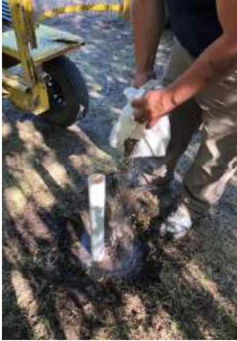
Colocación de grava
