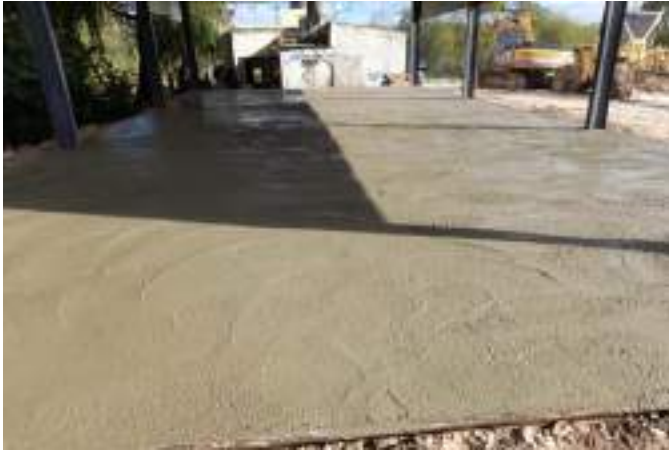
Foto 42. Construcción de tinglado para separación y clasificación de residuos.
