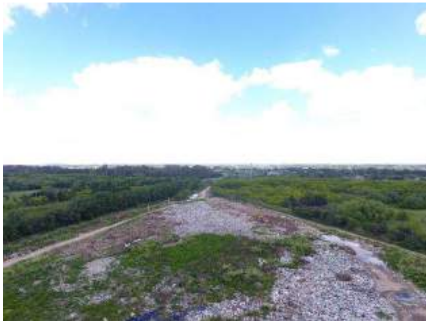
Foto 7. Vista general de la entrada al repositorio con las acumulaciones de RSU.
