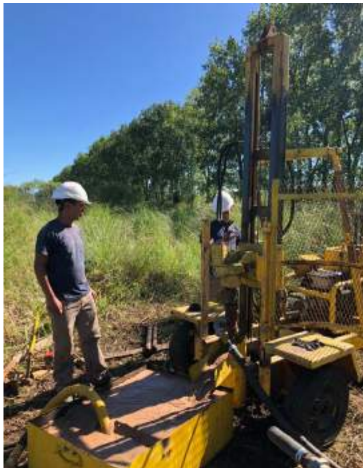
Construcción freaímetro F5
