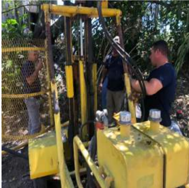
Construcción freaímetro F1
