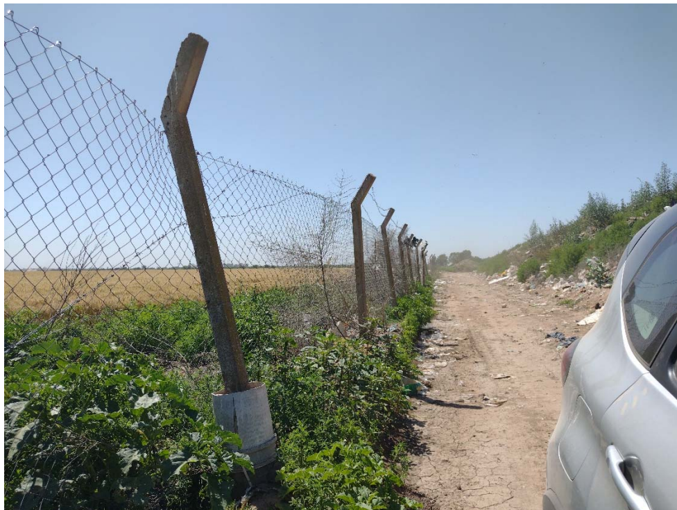
Foto 9. Calle lateral del BCA. Se ve el campo vecino y los residuos acumulados.
