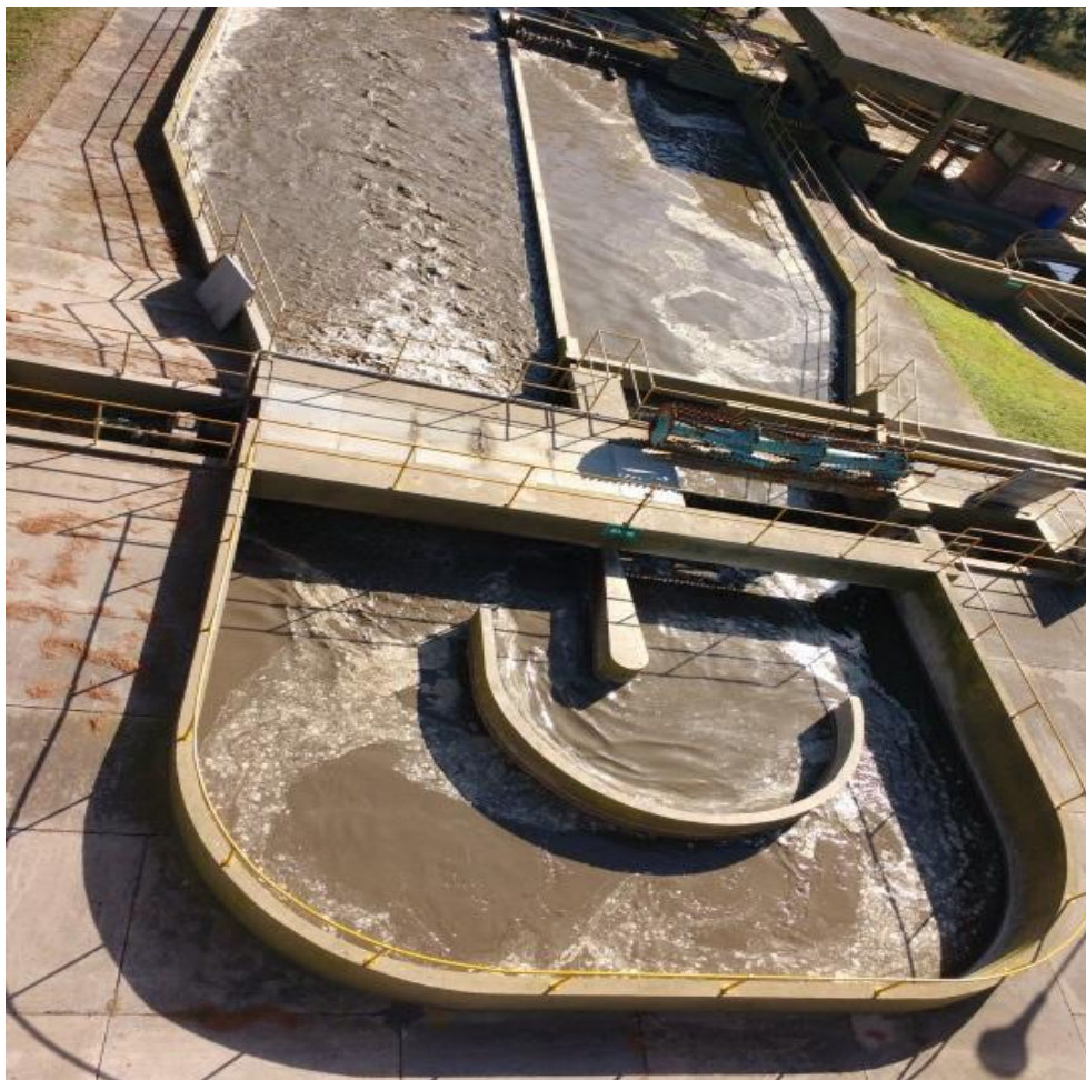
Imagen 8: Reactor de lodos activados
