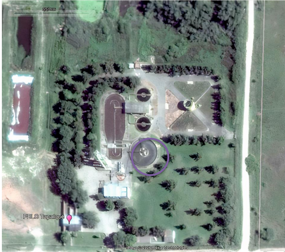
Imagen 1: Planta de Tratamiento de Líquidos Cloacales
