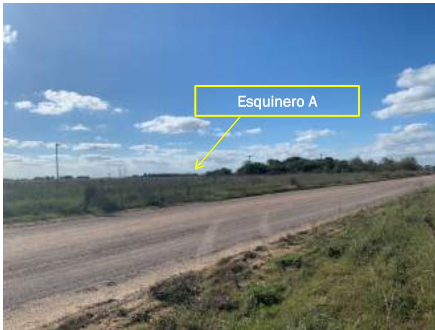
Fotografía N° 1: Vista al Norte desde la superficie, sobre la Ruta Provincial N° 20, donde se observa una Línea de Media Tensión (LMT) de 13,2 kV, el alambrado perimetral donde se encuentra en esquinero A.
