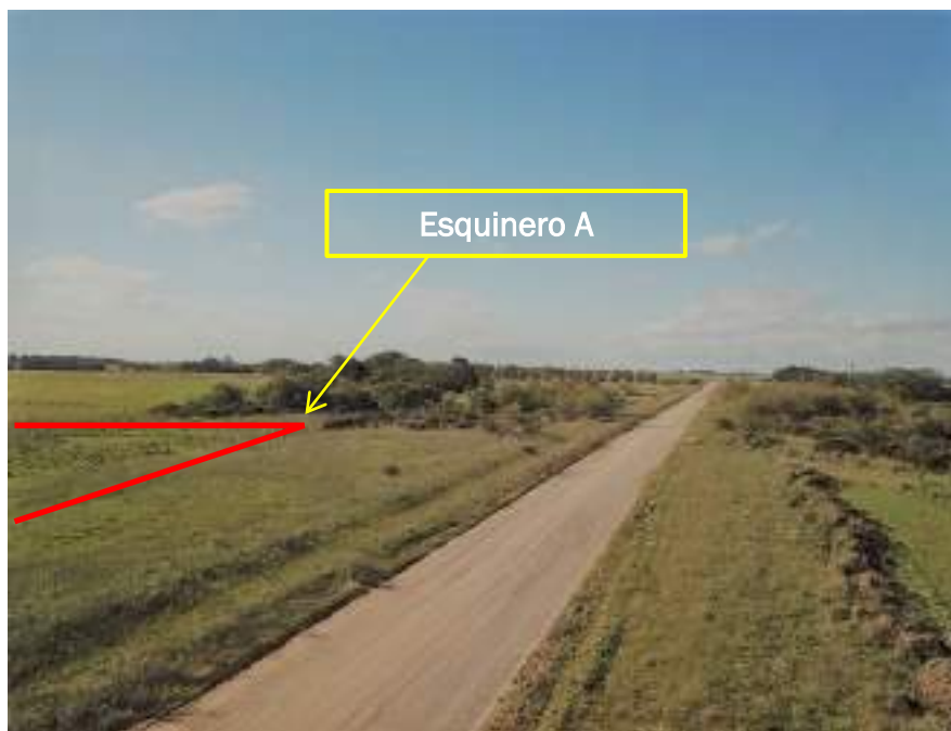
Fotografía N° 2: Vista al Norte desde la altura, sobre la Ruta Provincial N° 20, donde se observa una LMT de 13,2 kV, el alambrado perimetral y un monte donde se encuentra el esquinero A.
