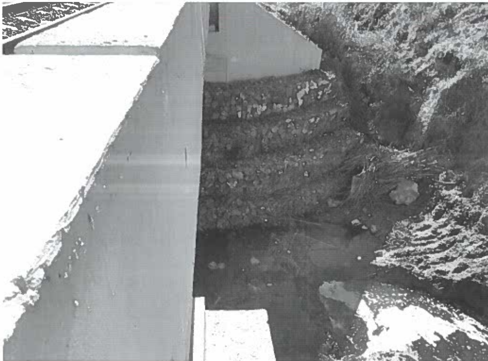
Detalle 13: Imagen correspondiente a estructura de gaviones dispuesta en puente ferroviario para protección de infraestructura y contención de terraplén.
