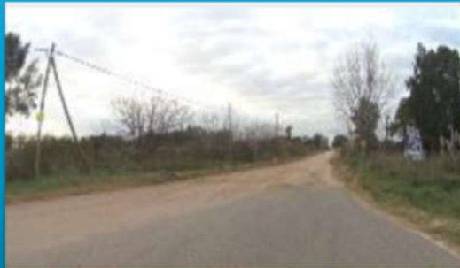
Prog. 0+000 Inicio del tramo, Int. RN 3
