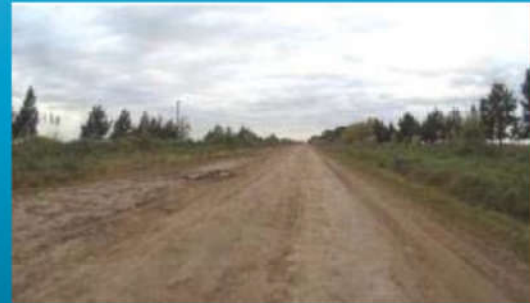
Prog. 7+700 Estado general del camino
