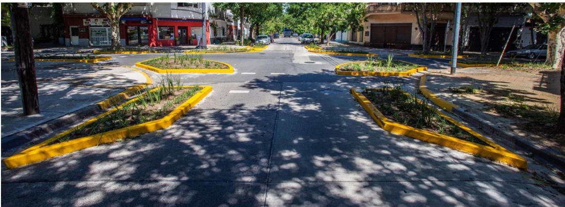
Imagen N° 6. Experiencia de “estrechamiento de calzada” en el barrio Villa Real de la Ciudad Autónoma de Buenos Aires (Obra ejecutada en 2019).
