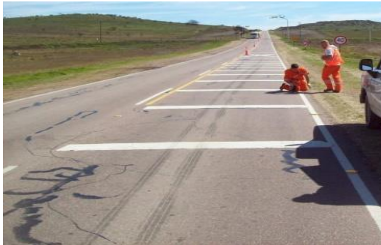
Imagen N° 41. Ejemplo Marcas Horizontales (Ruta Nacional 229, Provincia de Buenos Aires, Argentina).
