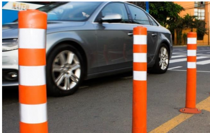
Imagen N° 36. Ejemplo de delineadores (Signo vial, Municipio Barranco, Perú 2017).
