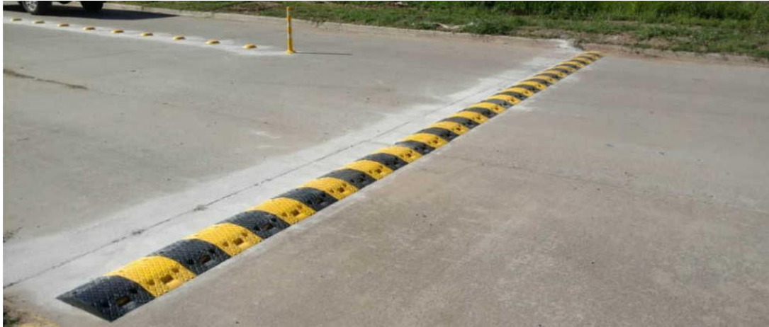
Imagen N° 17. Reductor de velocidad instalado en Parque Industrial Frondizi de la Ciudad de Junín – Provincia de Buenos Aires.
