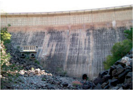
Figura 2.13. Complejo hidroeléctrico San Roque. Hacia la izquierda se distinguen dos válvulas que funcionan como descargador de medio fondo y hacia la derecha abajo, la salida del descargador de fondo. Fuente: SRH, MPFIPyS, 2012.
