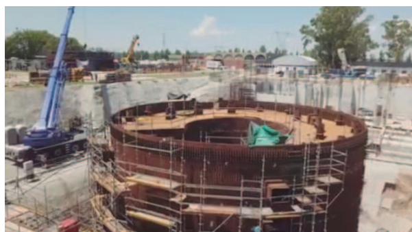
Construcción del Reactor Prototipo CAREM 25 (Crédito CNEA)
