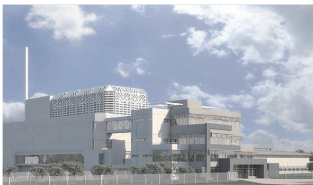
Proyecto RA-10, reactor de investigación multipropósito en construcción en el Centro Atómico Bariloche
