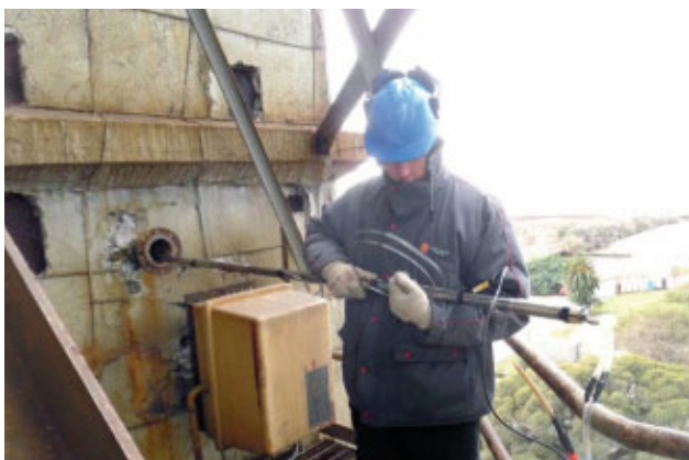
Ensayos de verificación de flujo.
