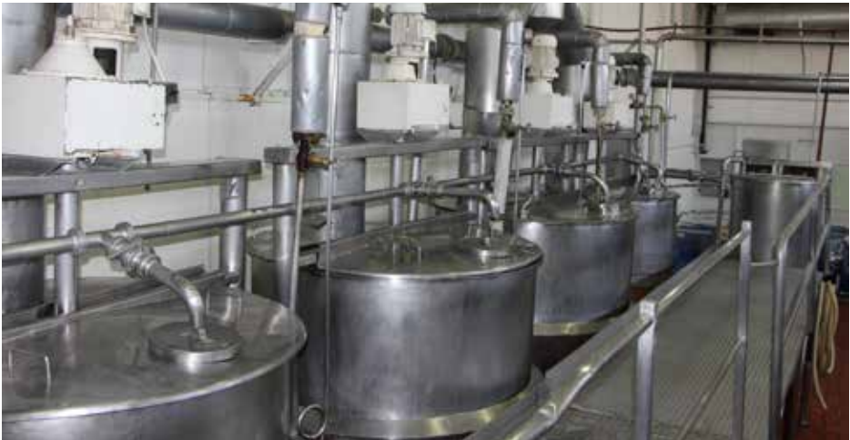
Sector pails, boca de carga. Fuente: SRT (2016)
