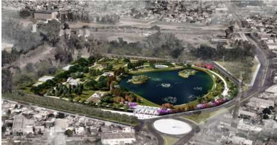
Imagen del Parque de la laguna, en ejecución
