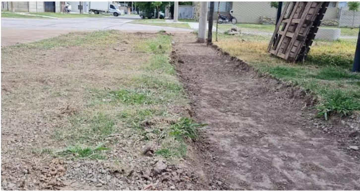
Construcción de vereda
