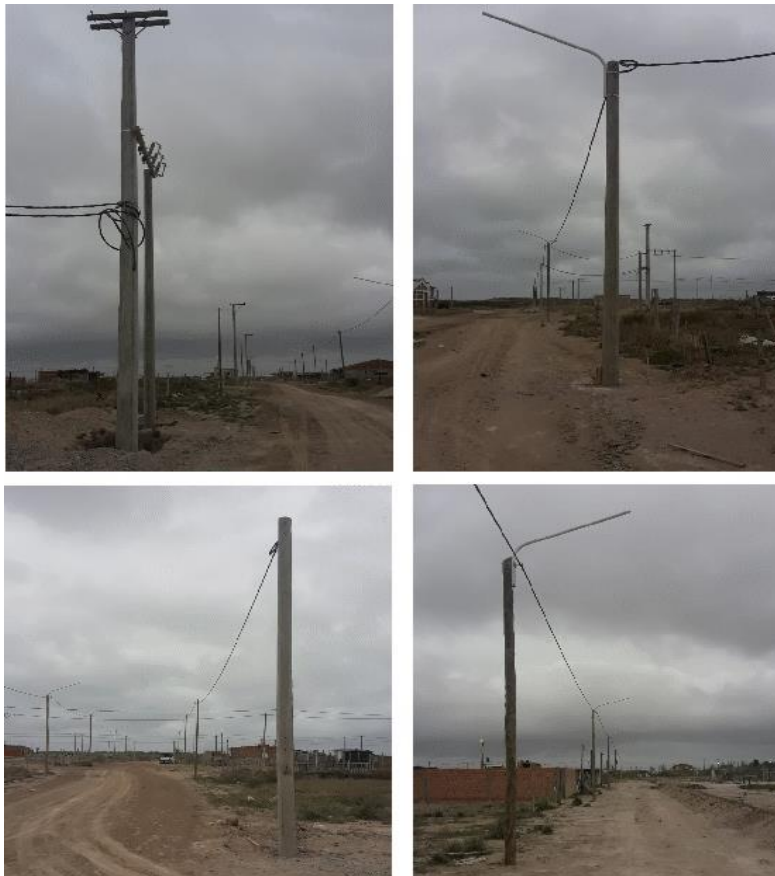
Avance de obra, infraestructura eléctrica Loteo Mi Bandera - San Antonio Oeste.
