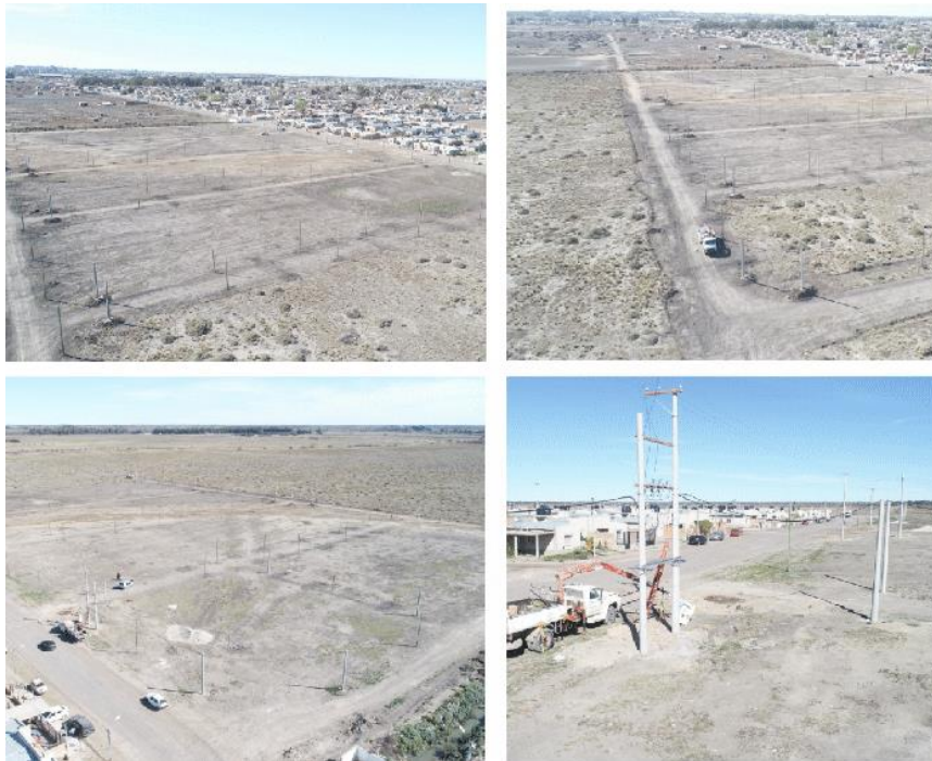
Avance de obra, infraestructura eléctrica Loteo Eucaliptus II - Viedma.
