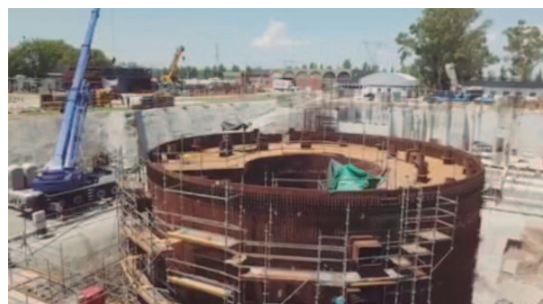
Construcción del Reactor Prototipo CAREM 25 (Crédito CNEA)
